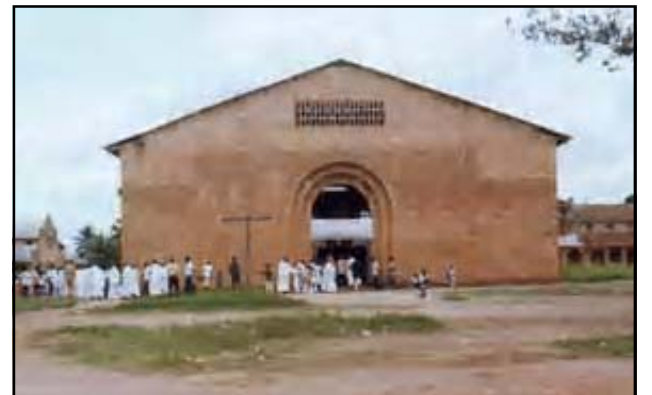
Façade principale de la cathédrale St Pierre Claver de Ouessou.
