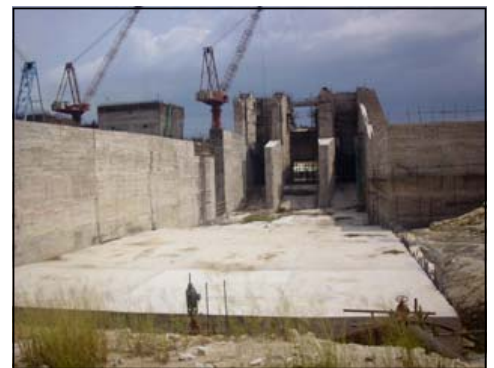
La partie de l'évacuation des eaux, pour assurer la sécurité du barrage et éviter son inondation.
