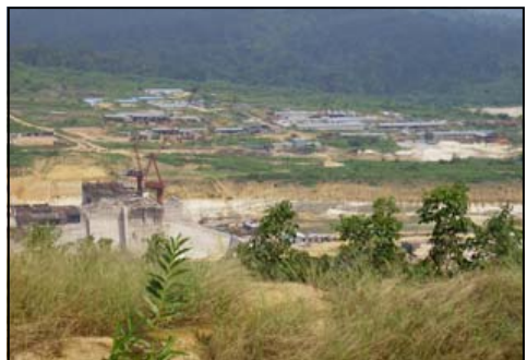
Le site du barrage à Imboulou.
