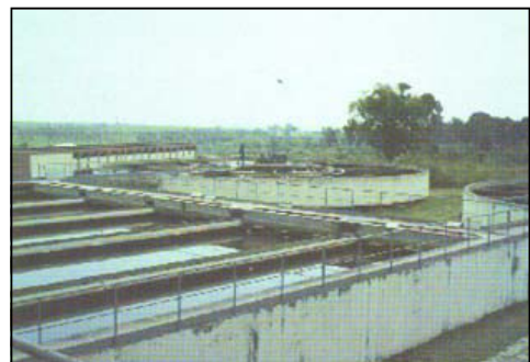
Une vue de l'usine de traitement d'eau de Djiri.
