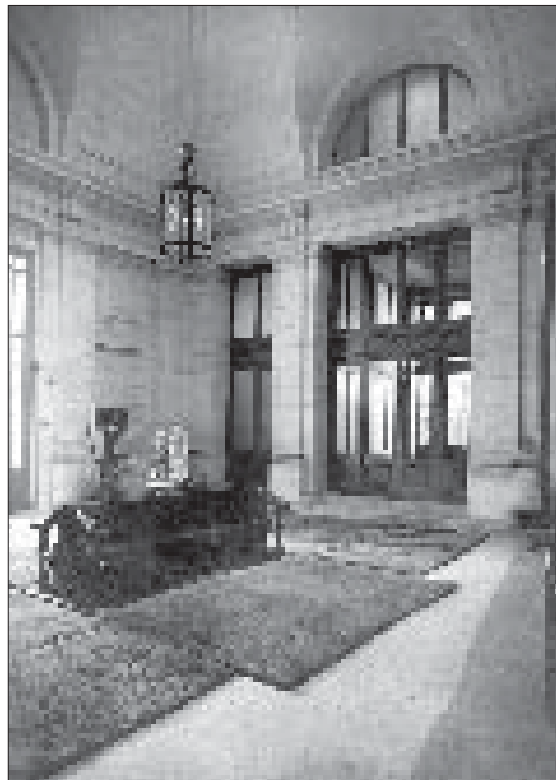
De inkomhal aan de Leuvensesteenweg (zaal 11) vóór het aanbrengen van de marmerbekleding in de jaren 1930. Copyright KMMA.
