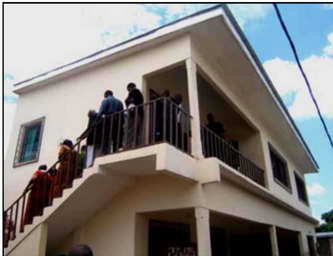
Une vue extérieure de la nouvelle bibliothèque.
