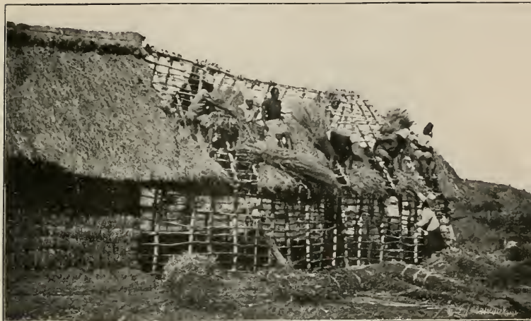
CAMP DE GOTTORP Une « paillette » en construction.
