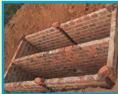
KINZANDI : 4 toiletten in aanbouw
