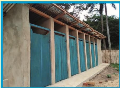
KUIMBA Secundair: nieuwe toiletten
